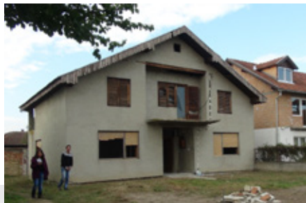
10月3日未整修前的外貌
